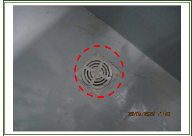
รูปที่ 2-32 ท่อรวบรวมน้ำเสียในห้องพัสดุฝอยรวม
