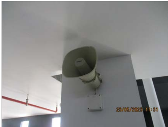
รูปที่ 2-52 ระบบเตือนอัคคีภัย (ต่อ)
