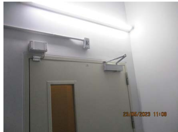
รูปที่ 2-71 ระบบควบคุมการเปิด-ปิดประตูในการเข้า พื้นที่บริเวณชั้นตาดฟ้าของโครงการ
