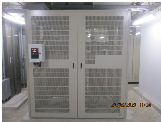
รูปที่ 2-38 หม้อแปลงไฟฟ้า
